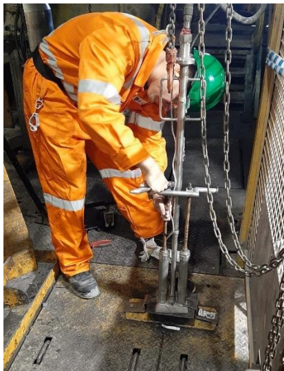
Fig. 3.1: Instalación de sonda en Olympic Dam.
