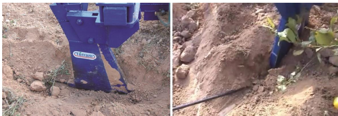
Figura 23. Instalación mecanizada de un sistema de riego por goteo subterráneo con arado topo. (Romero, 2022, diapositiva 11)
