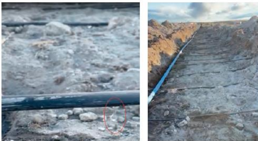
Figura 28. Sistema de riego por goteo subterráneo, disposición en terreno antes de ser cubierto. Fuente: Reckmann et al. , 2022.
