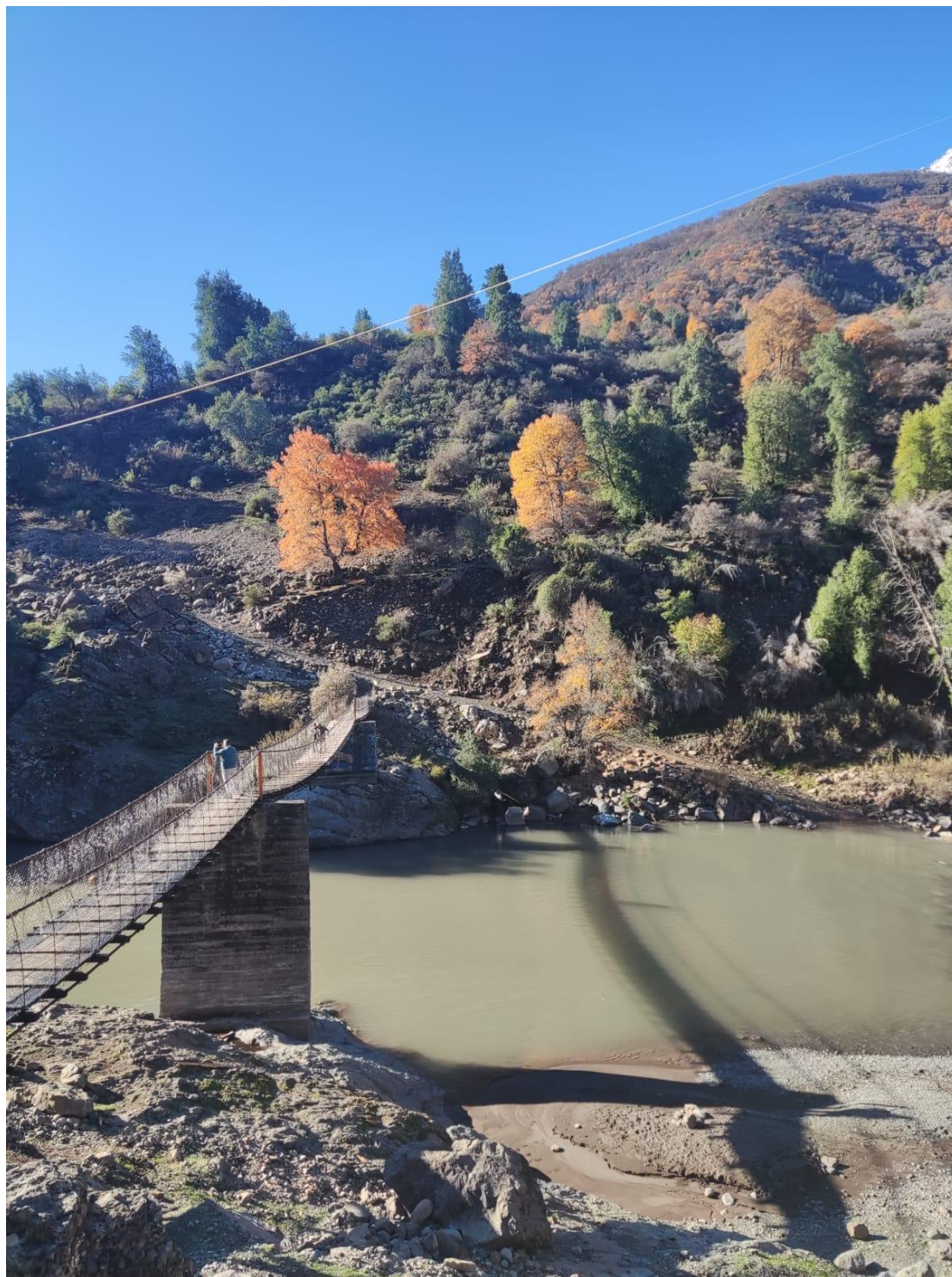
Figura 39. “Puente el Inglés”, ubicado en el sector de Pichirrincón, comuna de San Fabián de Alico. Fuente: “Registro fotográfico programas FIC”.
