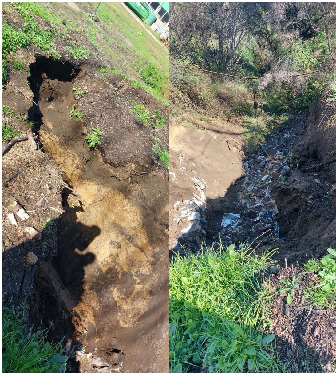
Figura 16: Deslizamientos de tierra y basura (terreno de la planta municipal de compostaje, Santa Juana) [imagen propia]
