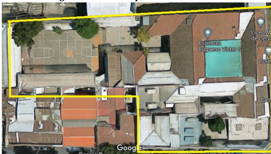
Figura N°6 Vista Superior Fundación Fré
