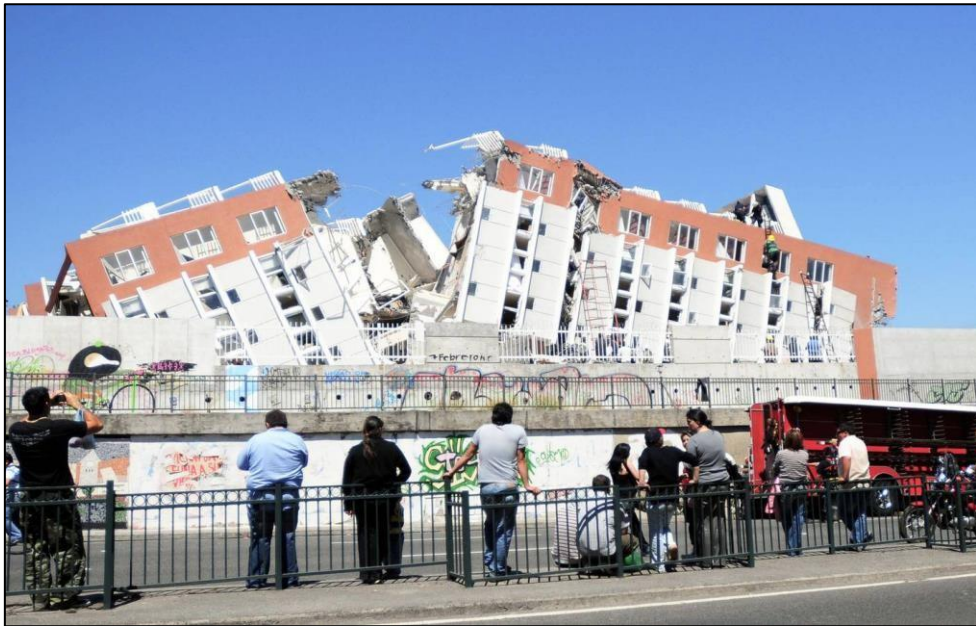
Figura 1. Edificio Alto Río caído debido al terremoto del 2010.
