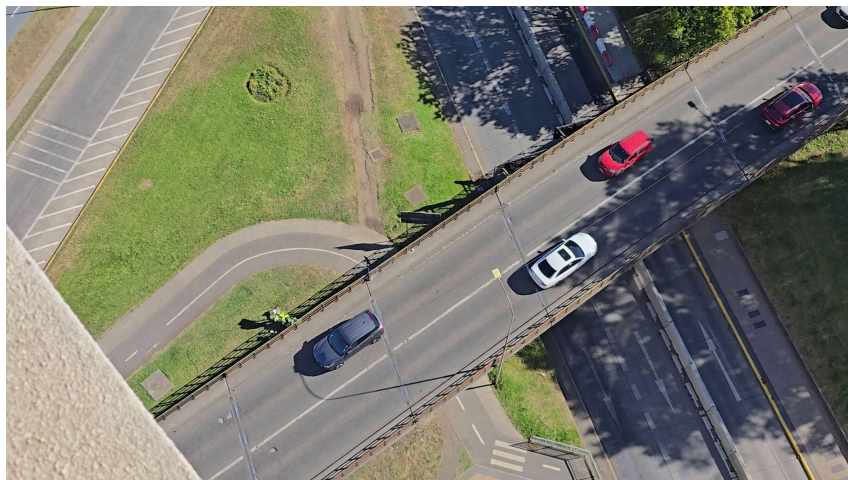
Figura 10: Toma de la primera cámara.
