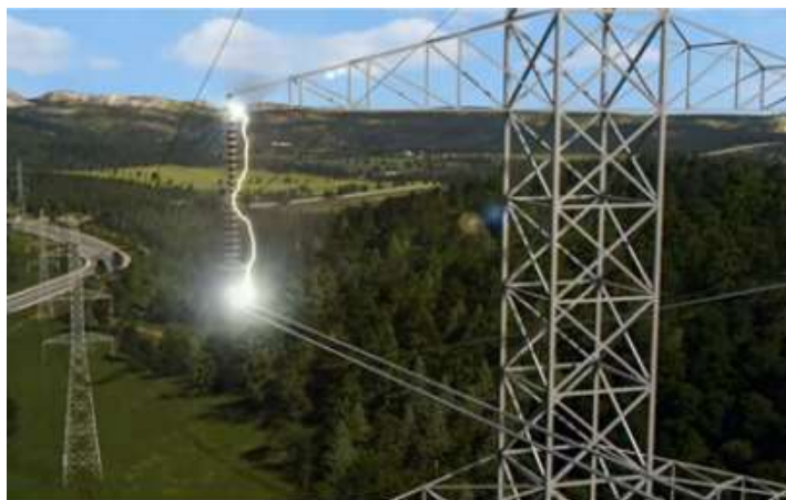
Fig. 1.2: Falla en cadena de aisladores. Fuente: General Electric.
