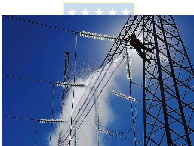
Fig. 1.1 Cadena de aisladores. Fuente: Sector Electricidad.
