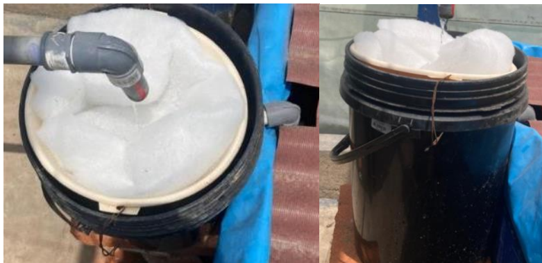
Figura 5. Filtro mecánico de flujo radial para remoción de sólidos con filtración de hasta 100 micras.
