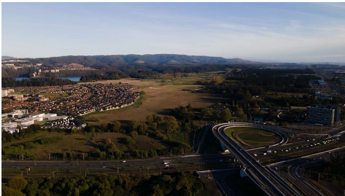
Fig. 8: Encapsulamiento Sistema Humedal Los Batros por infraestructuras viales Fuente: Elaboración Propia 2025.
