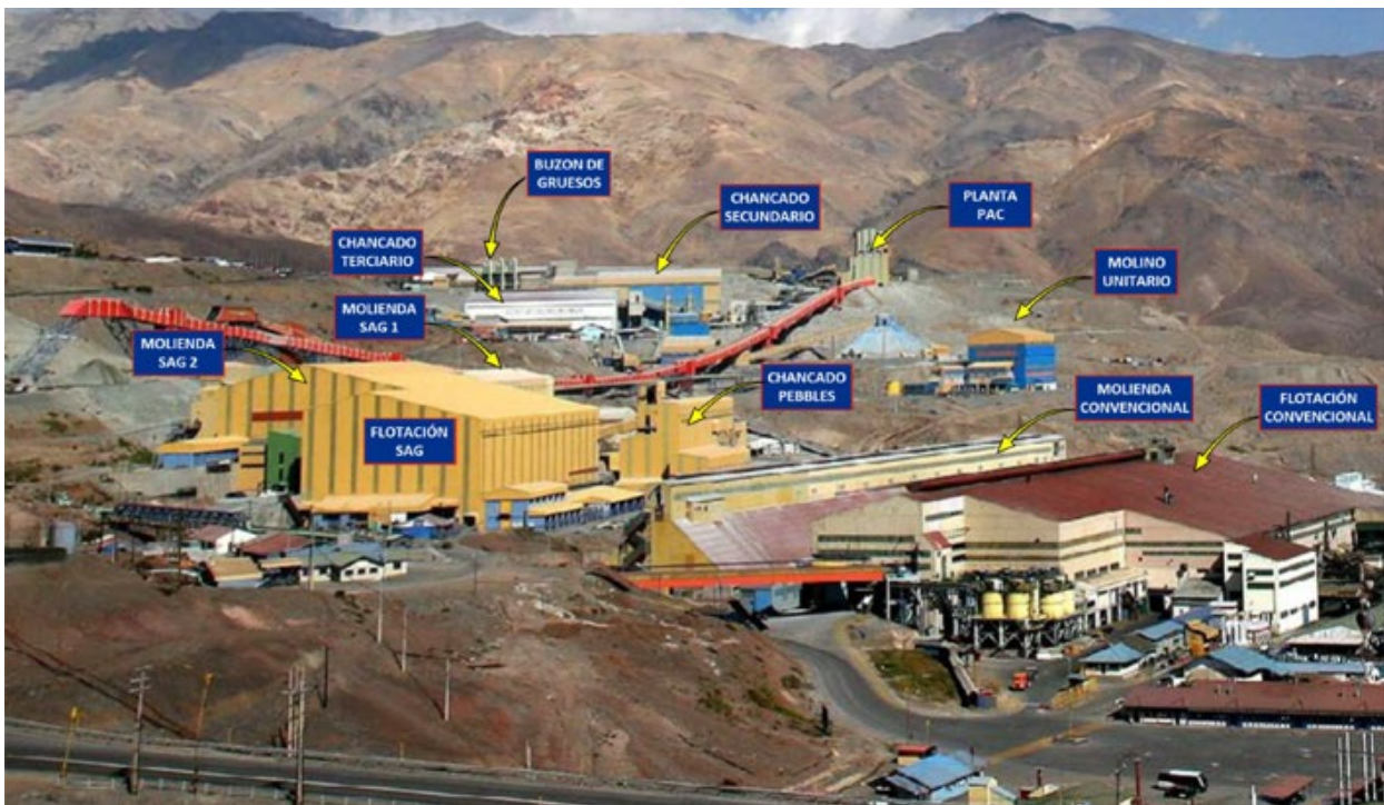
Figura 2. Vista operaciones unitarias Planta Concentradora Colón, Codelco El Teniente (Codelco El Teniente, Gerencia de Proyectos, 2022).
