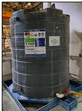
Figura 5. Estanque de soda cáustica.
