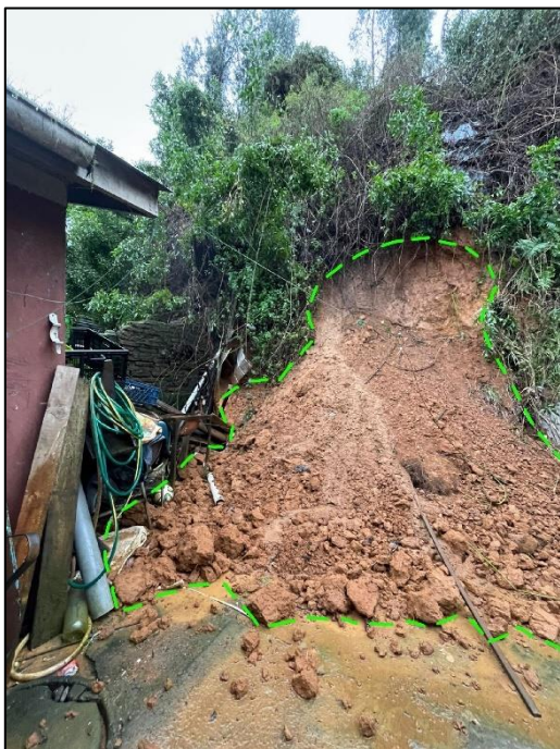
Fotografía 5.5.: Deslizamiento traslacional de suelo marcado por línea segmentada, Julio Rivas, comuna de Lota. Tomada por Abisag Ortega, 2022.
