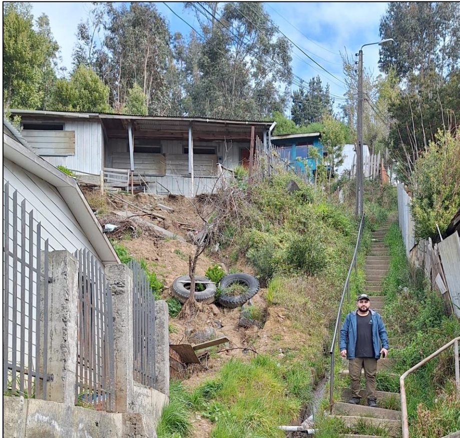
Fotografía 4.2: Deslizamiento de suelo en sector Junquillo Bajo. Tomada por Felipe Baltierra.
