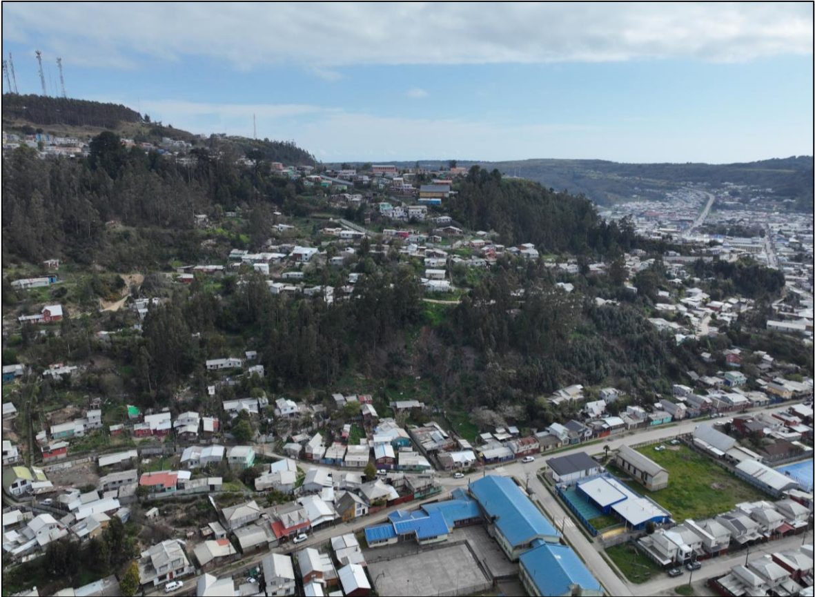
Fotografía 4.5: Vista general aérea de sectores con algunas RM. Tomada mediante dron. Al este sector Diagonal Freire, en el centro Junquillo Alto y al oeste Junquillo Bajo.
