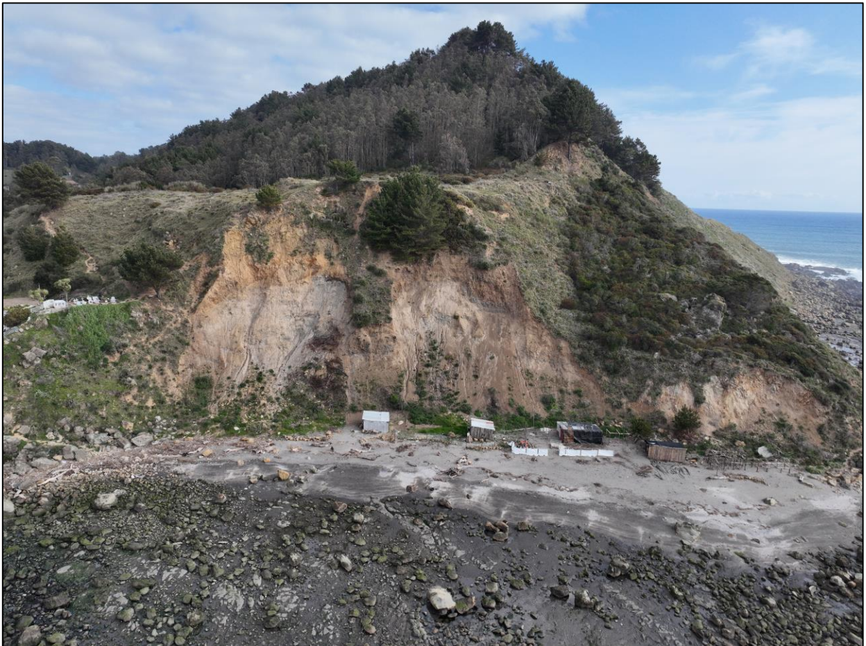
Fotografía 4.1: Deslizamientos de suelo en sector Bocalebu. Tomada mediante dron por equipo MA Biobío. Se presentan dos deslizamientos: EA63 (a la izquierda) y EA 64 (a la derecha).
