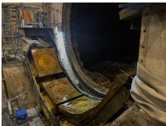
Anexo 10: Pads y bronces del trunnion en la zona de descarga.
