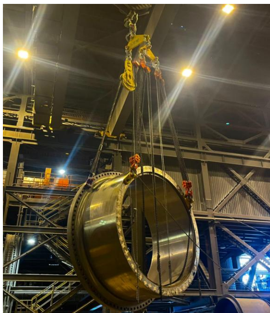
Anexo 30: Nuevo trunnion de descarga suspendido con sistema de izaje.
