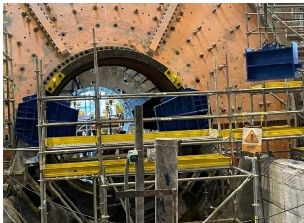
Anexo 22: Izaje e instalación de las consolas del dispositivo de extracción.
