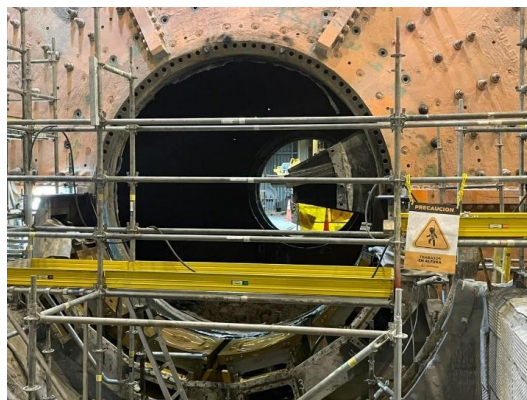
Anexo 9: Componentes de descarga retirados en el molino SAG 02.
