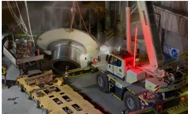
Figura 4: Corte de eslingas en izaje de trunnion-adapter, Chuquicamata (2025).
