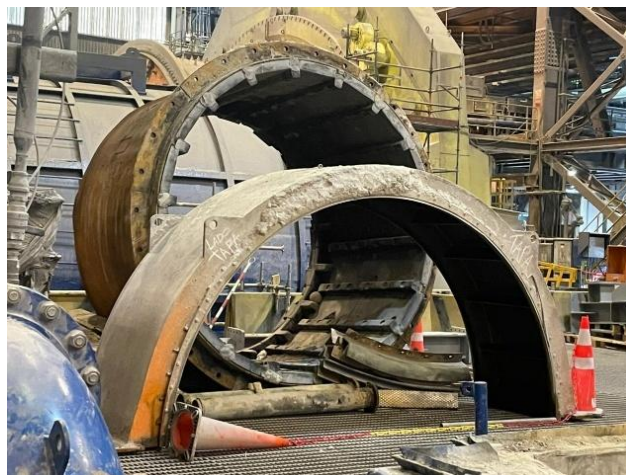
Anexo 6: Trunnion liner y cubre descansos desmontados.
