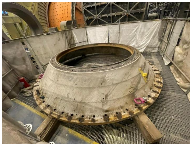
Anexo 7: Adapter retirado mediante maniobras de izaje.
