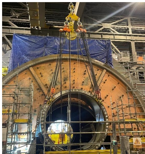
Anexo 32: Montaje del trunnion de descarga en apoyo de bronce.
