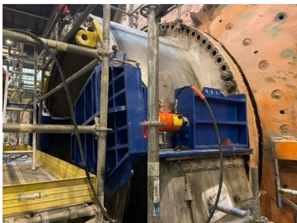
Anexo 23: Accionamiento del dispositivo de extracción del trunnion de descarga.
