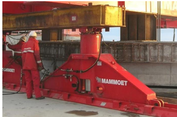
Figura 6: Sistema de deslizamiento controlado para transporte horizontal (skidding system) [6].
