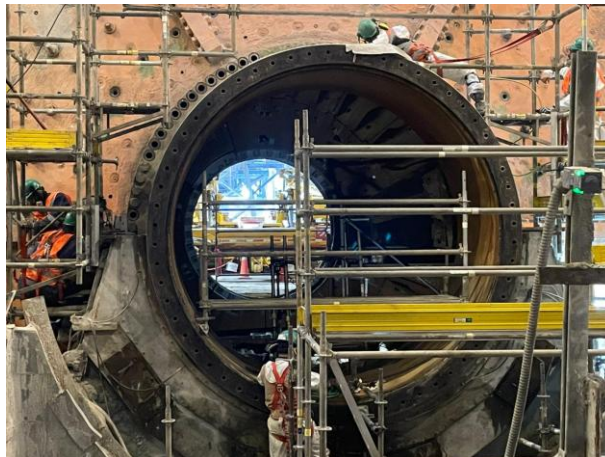
Anexo 21: Instalación de andamios y retiro de pernos inteligentes en la unión trunnion-tapa.
