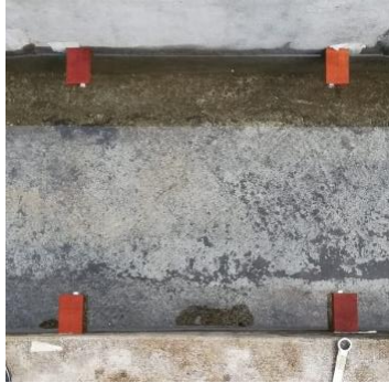
Figura 4.10: Soportes de anclaje instalados en la pared del canal
