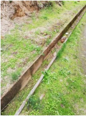
Figura 2.8: Canal de cemento al costado del LTA
