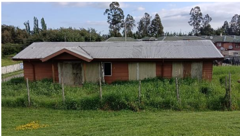
Fotografía 15: Sede social en desuso Villa Jorge Teiller
