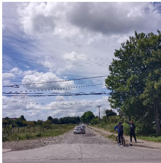
Fotografía 5: Acceso sin pavimentar a Strip center, Villa los reyes y Villa alem. Fuente: Registro personal
