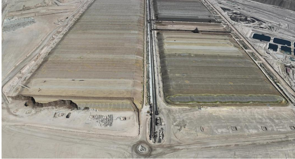
Figura 38: Vista área de pila 1 y pila 2 (Costella S.A, 2025)
