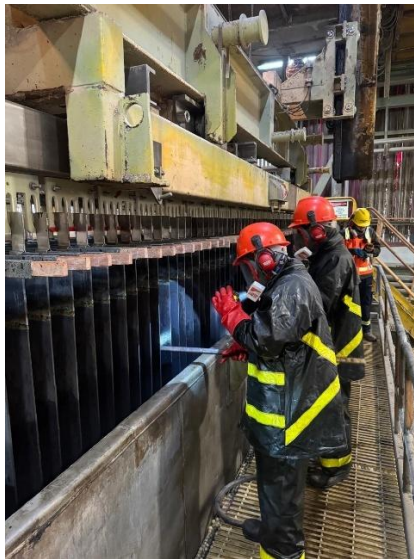
Figura 66: Actividad de lavado de ánodos (Imagen propia, 2025)
