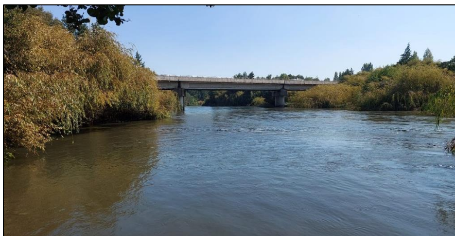
Figura 4. Vista general de la estación GU10, en el fondo se observa el puente Guaqui.
