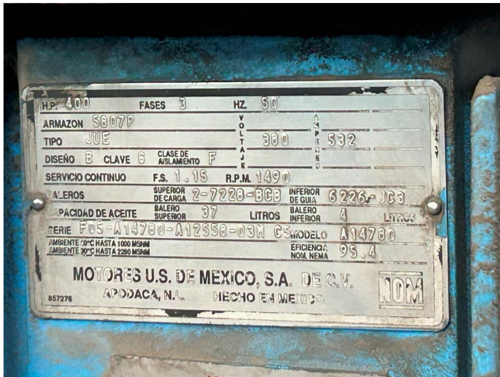
Figura A 13: Datos de placa de bomba de elevación de Cerro Chepe
