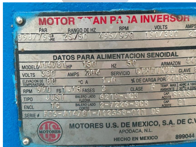
Figura A 13: Datos de placa de bomba de elevación de Cerro Chepe
