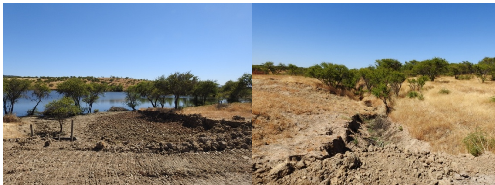
Figura 2. Condiciones actuales del embalse y su canal de descarga.
