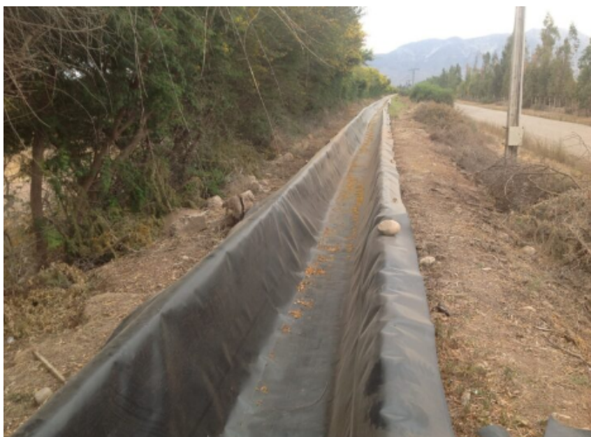
Figura 10. Revestimiento de canal con geomembrana HDPE. Fuente: Technoflow.
