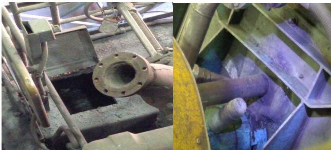
Figura 56 C. Cubierta de cajón abierta entre primera y segunda limpieza b) Sellado post-mantenición en celda
