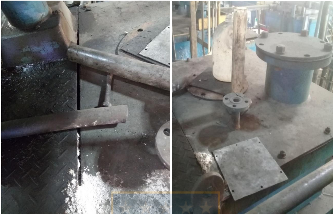
Figura 46. a) Abertura cajón ST-17 b) Abertura cajón ST-17.
