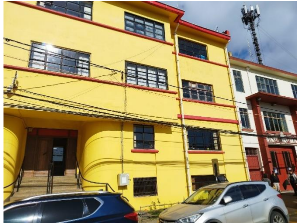
Figura 6: Fachada principal municipalidad – muro Oeste
