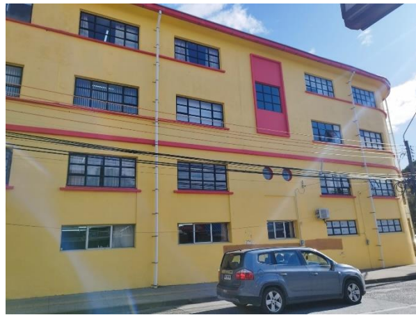
Figura 7: Muro Norte Municipalidad
