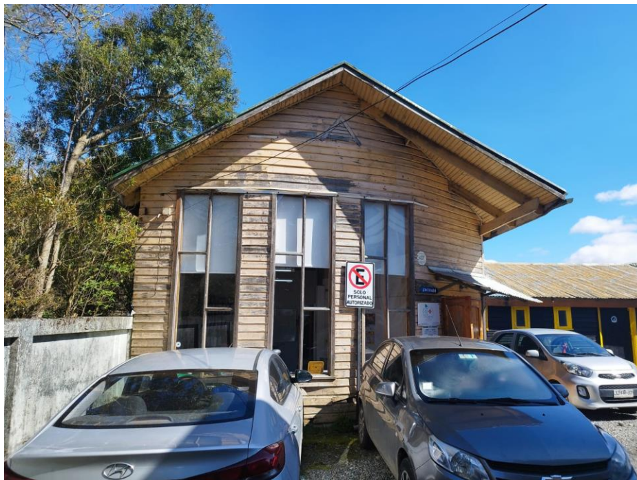
Figura 5: Fachada principal veterinaria
