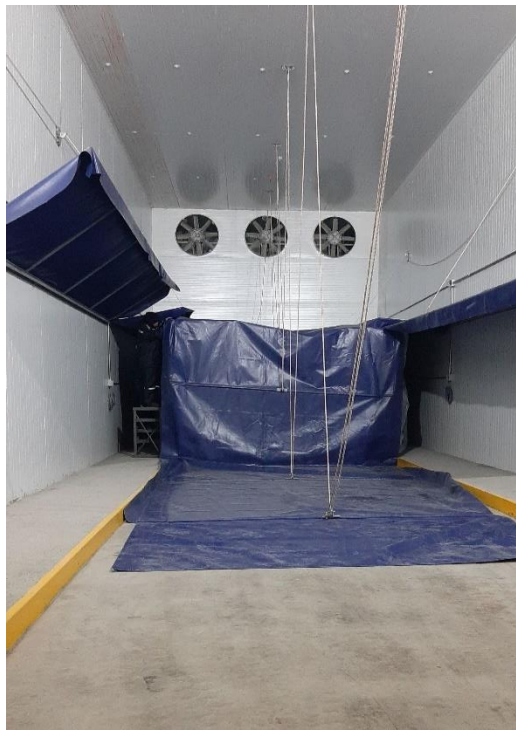
Figura 22. Cámara de pre-frío para producto terminado.
