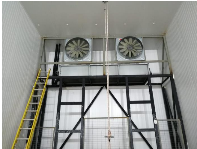
Figura 23. Motores en pre-frío para producto terminado.
