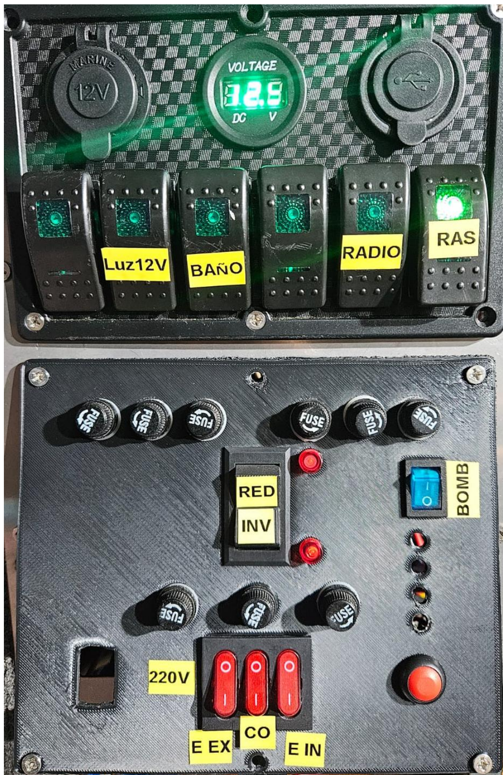
Figura 0.6 Montaje tablero de control
