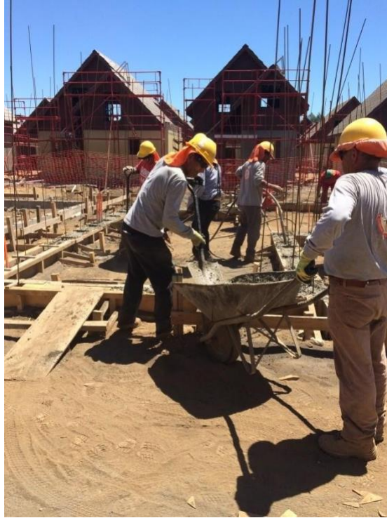
Imagen 3. Trabajos sobre cimientos y trabajo con pala
