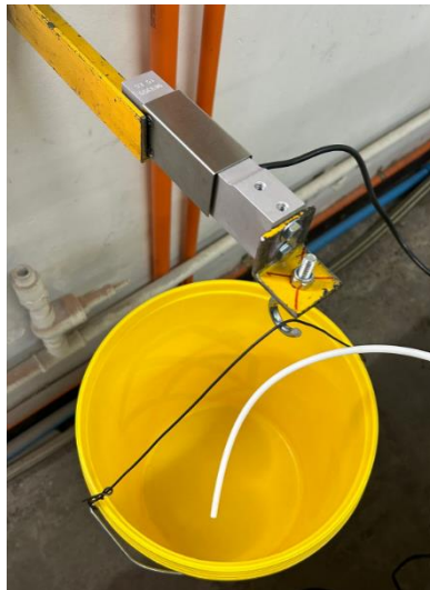
Figura 21: Sistema de medición de agua recolectada,
