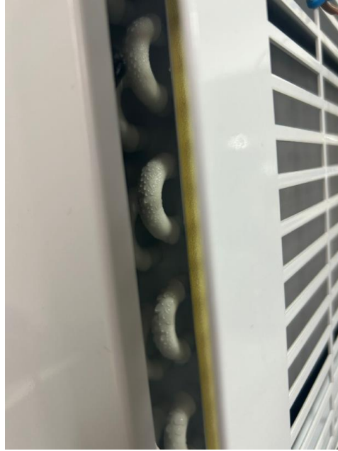
Figura 28: evaporador descongelándose
