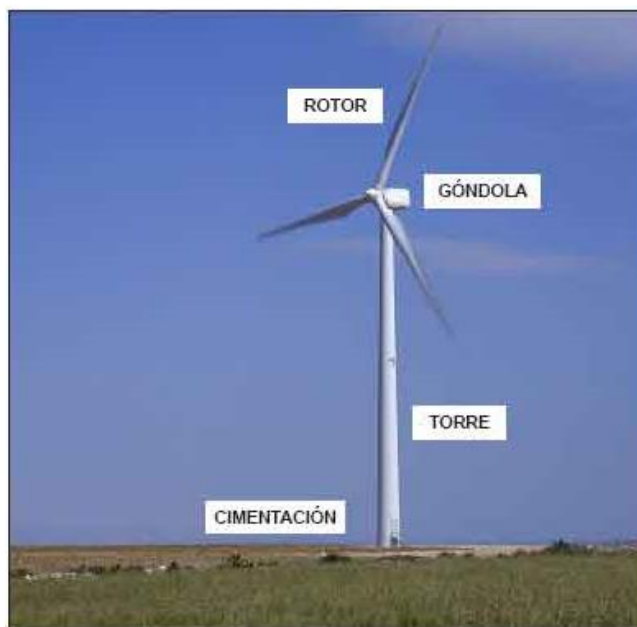
Figura 1: Principales componentes de un aerogenerador de eje horizontal (fuente: [4])
