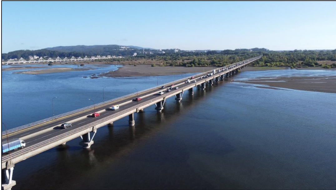
Figura 3.1. Fotografía aérea puente Juan Pablo II. Fuente: Fotos de B. Catalán (2025), Fondecyt Ini. No. 11230092.
