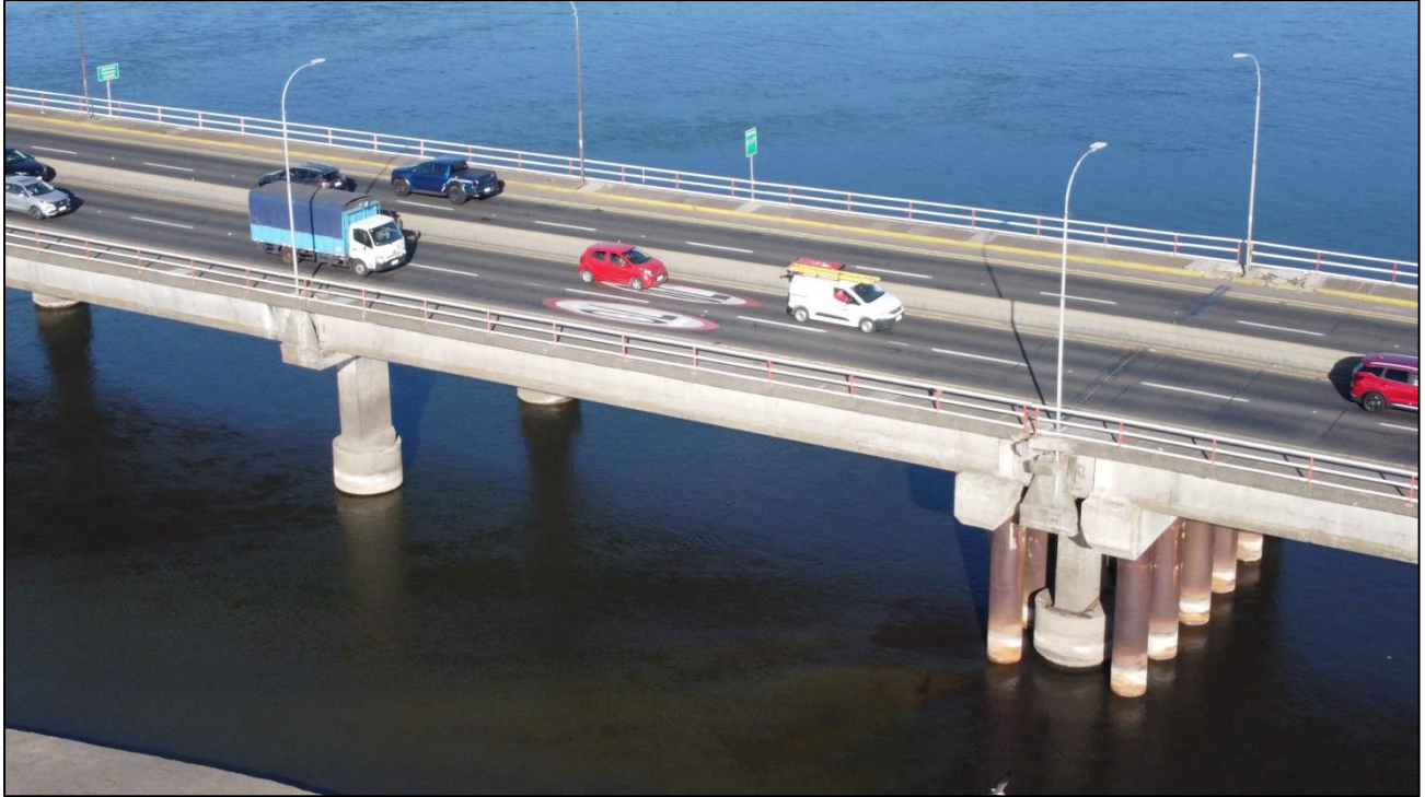
Figura 3.3. Fotografía del refuerzo en las cepas del puente.
