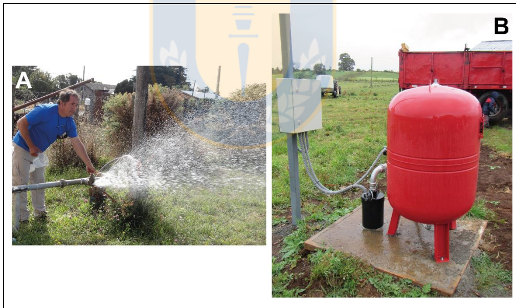
Fotografía C.1: Extracción de agua recién bombeada. A) Pozo con llave previa a estanque. B) Pozo con llave en estanque.
