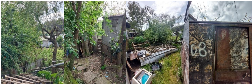
Fuente: Elaboración propia. Fotografías capturadas en recorrido en terreno: se puede observar poca accesibilidad, terreno desnivelado, deterioro el lugar producto de escombros lanzados por las personas que viven en los alrededores.
