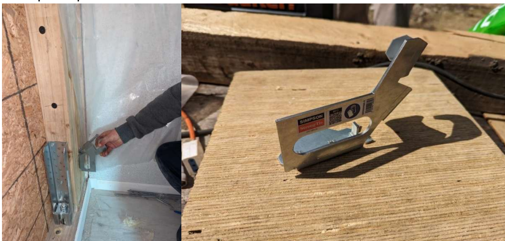
Imagen 17 – Guía metálica instalación tornillos SWD330X8. Fuente: Simpson Strong-Tie
