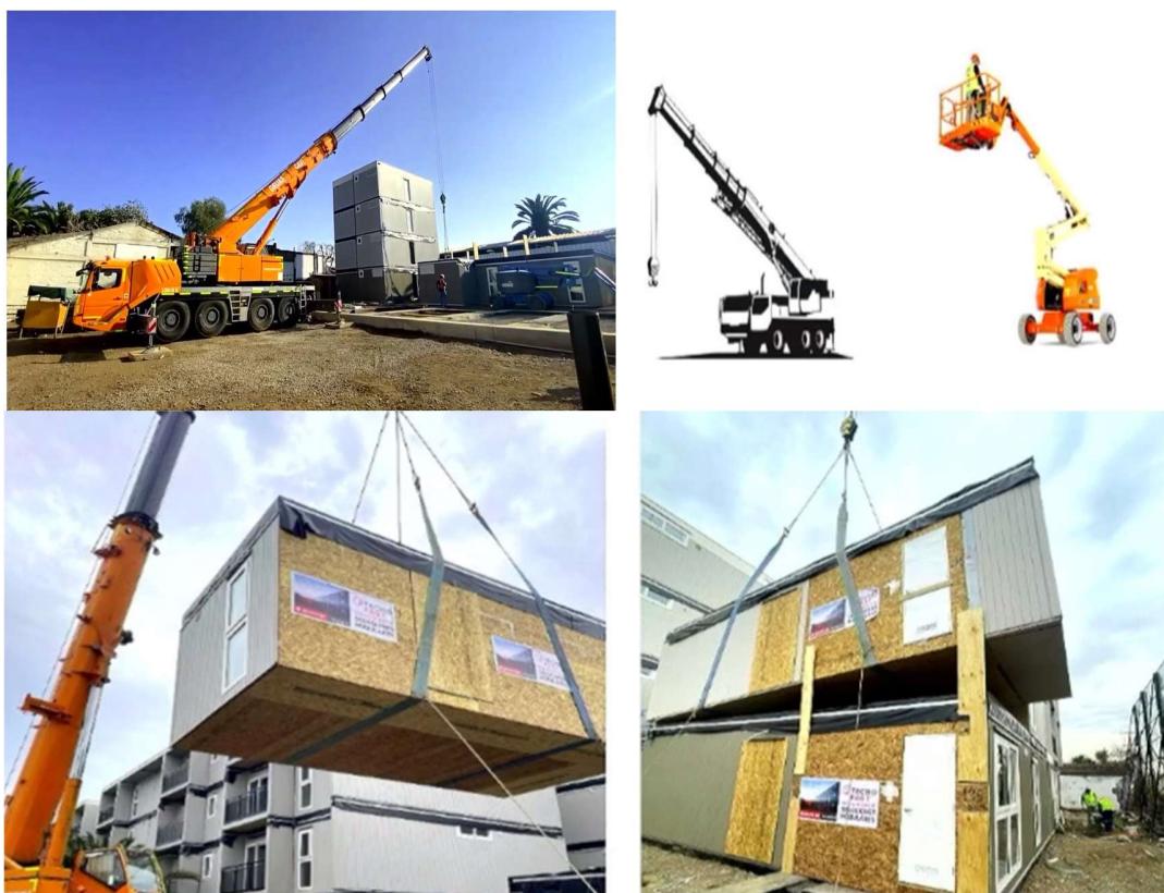
Imagen 7 - Detalle secuencia de Montaje Módulos. Fuente: Tecnofast
