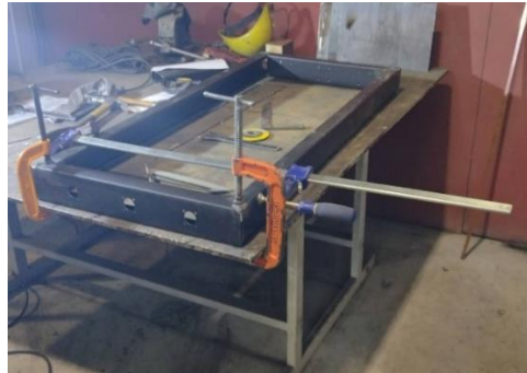
Figura 5.2.3: Proceso de unión de los perfiles en el taller mecánico
