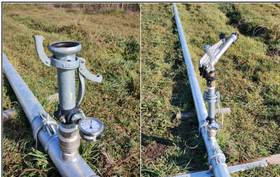
Figura 6. Conexión entre tubería principal de 4" y aspersor Duplex.
