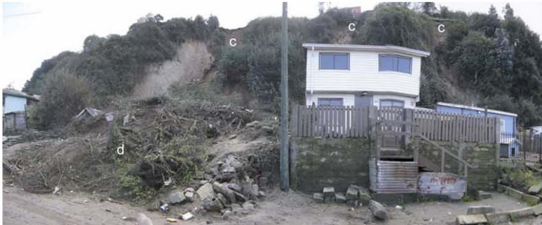
Figura 23. Deslizamiento Cerro La Pólvara, Calle Prieto, causando la destrucción de una vivienda y tres fallecidos. Fuente: (SERNAGEOMIN, 2005)
