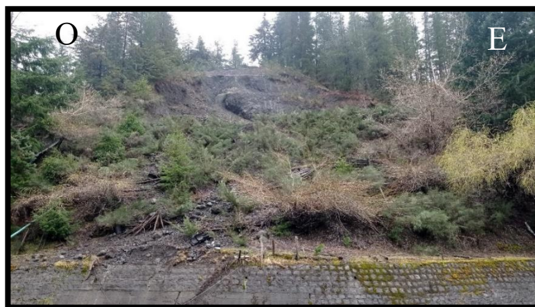
Figura 7.8: Remoción al costado del canal, con presencia de vegetación desplazada junto con el suelo.
