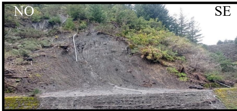
Figura 7. 9: remoción con presencia de agua corriente.
