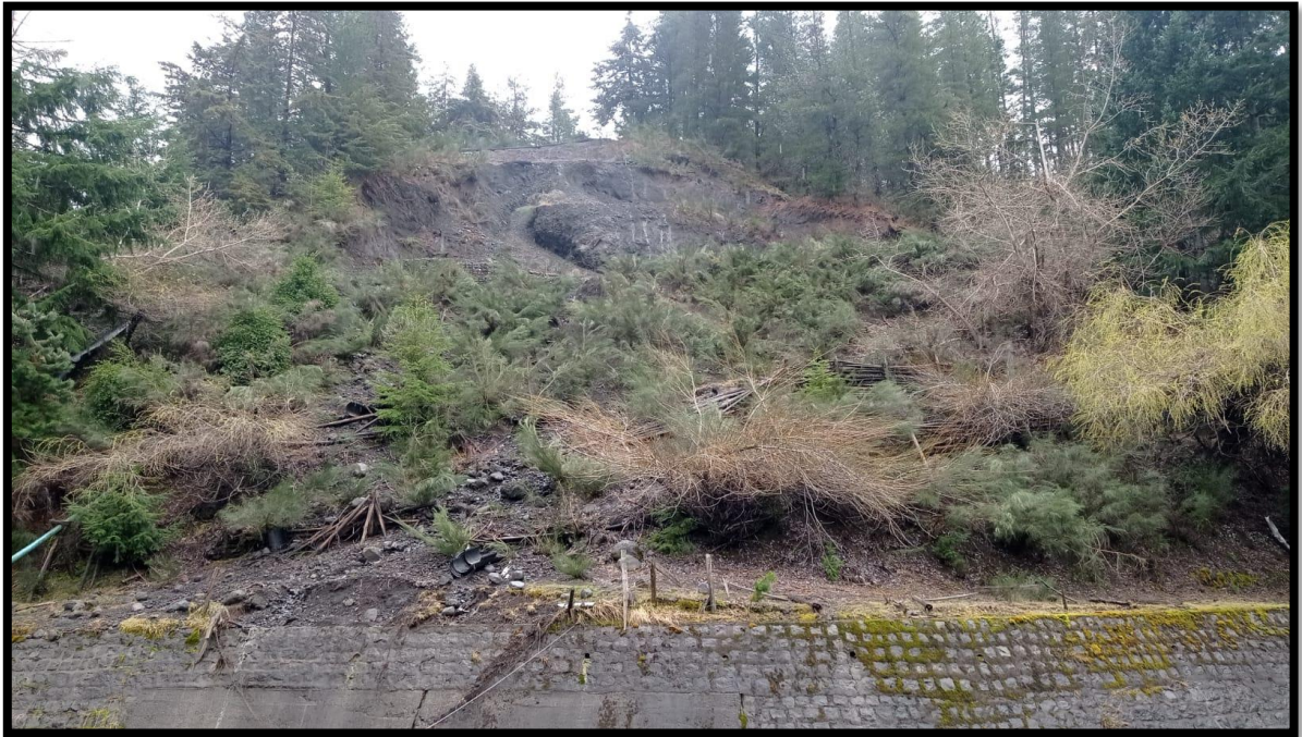
Figura 7.13: Remoción con evidencia de medidas de mitigación.
