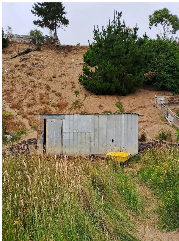
Fotografía 12. Bodega de almacenamiento de algas. Fotografía por autor.
