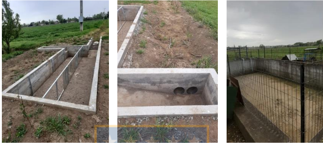
Figura 12 Desarenador y decantador ubicado en la Universidad de Concepción, campus Chillán.
