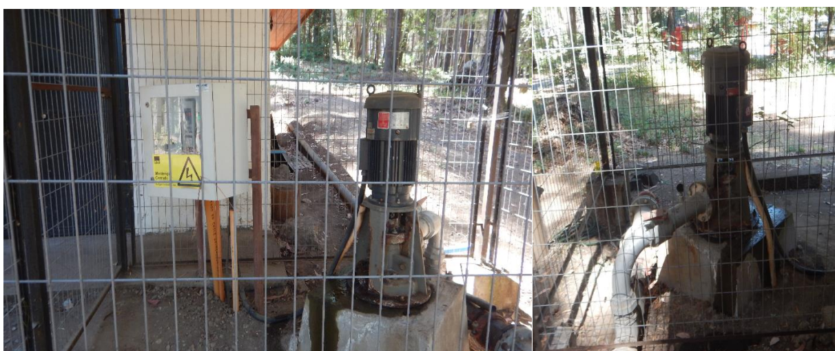
Figura 5.5: Instalación pozo Termas de Catillo
