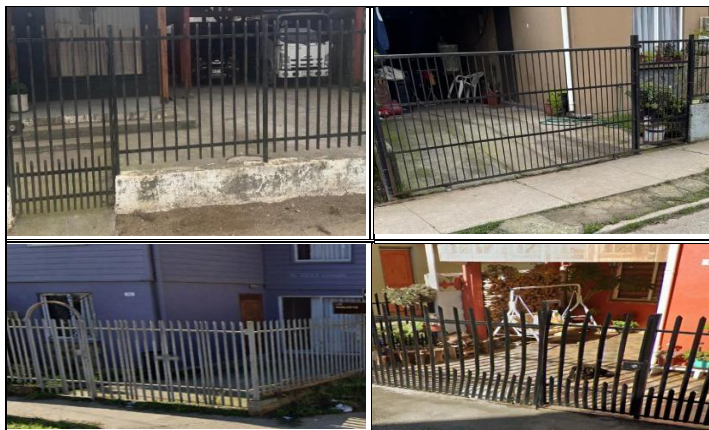
Figura N°21: Vivienda con presencia de algunas barreras
