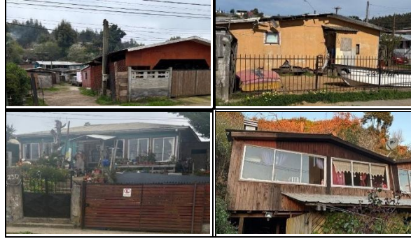
Figura N° 10: Edificaciones de madera o materiales de calidad inferior
