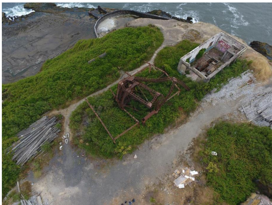
Fotografía N°6 Plano Aero Pique Alberto con cabría destruida, motor saqueado y desechos públicos en Sector Chambeque. Elaboración Propia, 2023.
