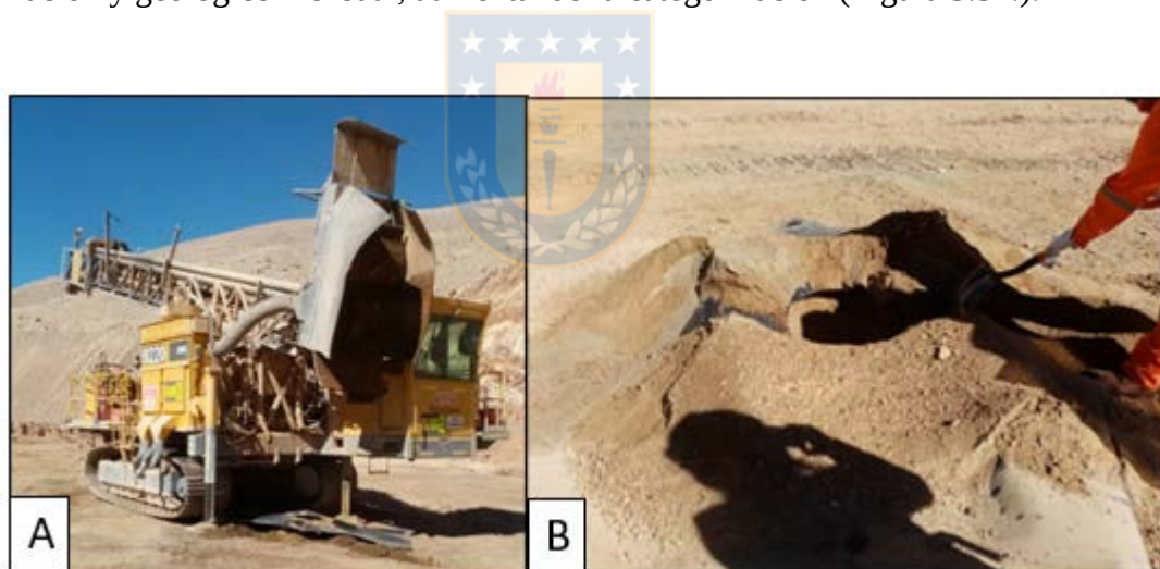
Figura 3.32. Realización de pozos monitores geológicos. A) Perforadora DML de pozos de producción. B) Pozo monitor a 18 m, se observa la carpeta separando el cutting a 9 m y 18 m para muestrear de forma más representativa según test de heterogeneidad.
